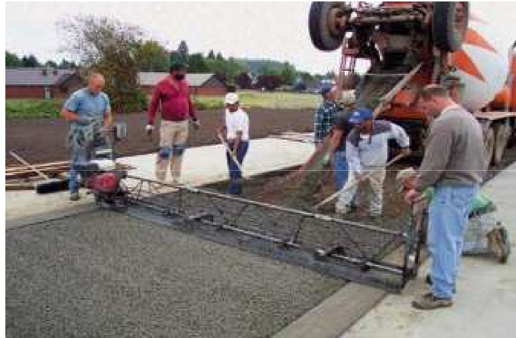
Colocación del hormigón y extendido con regla vibratora (R. Banka)
