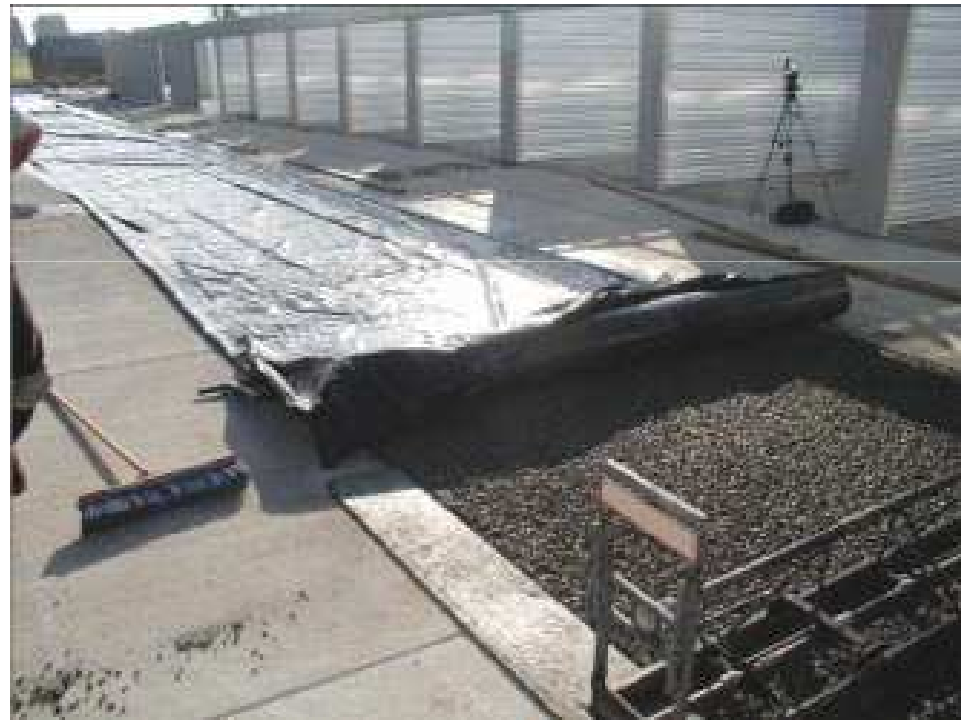
Pavimento de hormigón cubierto con lona de plástico (R. Banka)
