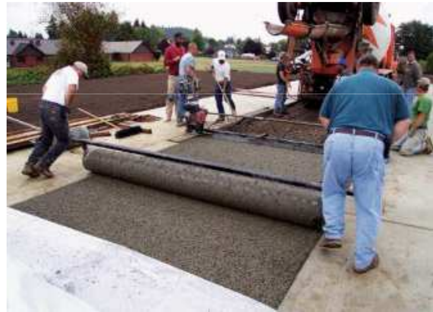
Compactación de hormigón poroso con rodillo de acero (R. Banka)
